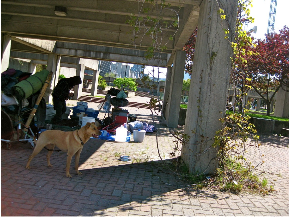
La Niches des Maîtres in Square Viger. Lindsay Ann Cory. 2011. Photograph
