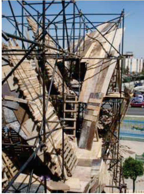
Figure 55. Reconstrucción del muro. Détail. Antonio O'Connell (2008)
