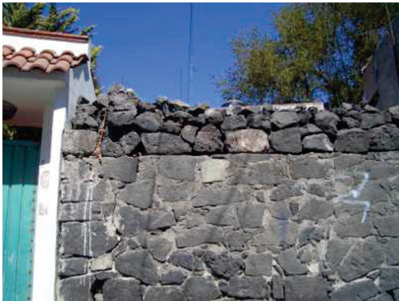
Figure 50. Pierres volcaniques, murs et façades. Image pris par Nuria Carton de Grammont. Ville de Mexico (2011)
