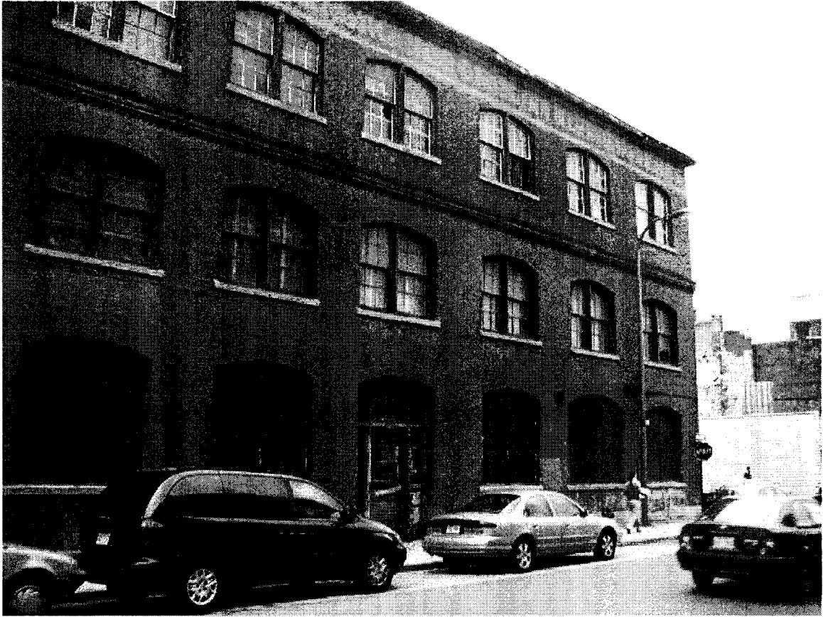
Fig. 3 735 Ottawa Street Façade before renovation c. 2004. Source: Architectural firm, L'Office de l'électisme urbain et fonctionnel .
