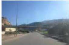
46- Nahrmot Baabdat Bridge 8
