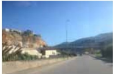
46- Nahrmot Baabdat Bridge 7
