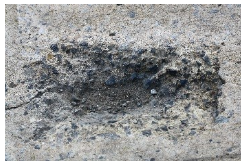
(d) Spalling on Lower Slab
