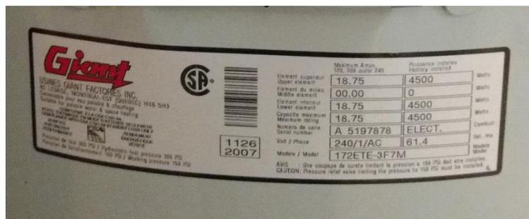
Figure 52 : DHW Tank Label
