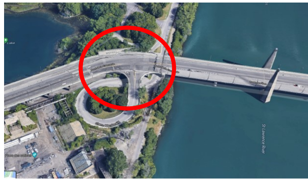
(d) Bridge 4: Chemin Macdonald
