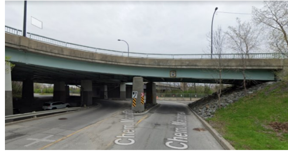
(d) Bridge 4: Chemin Macdonald
