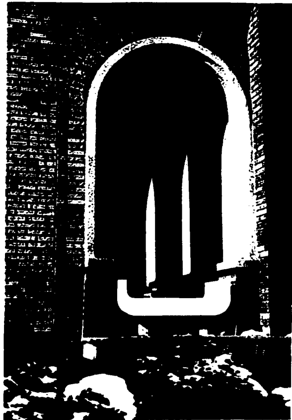
Fig 11 : Détail côté sud du portique d'entrée
