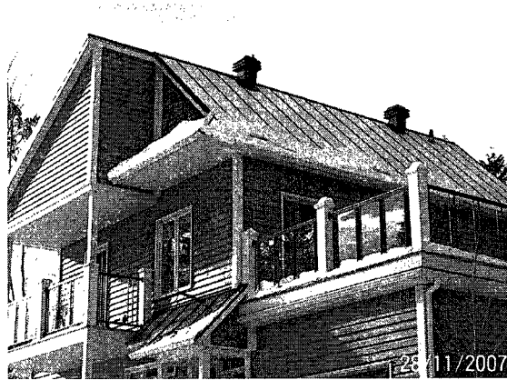
(d) 12:00pm north roof
