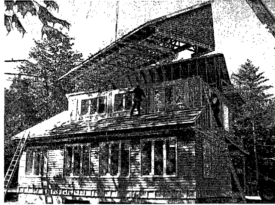
(b) BIPV/T module
