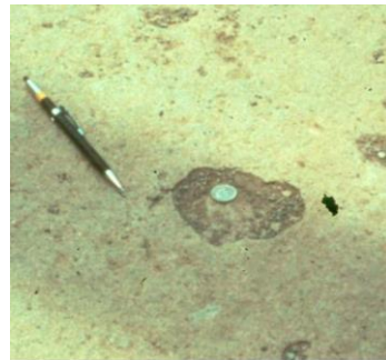
(d) Scaling on a deck
