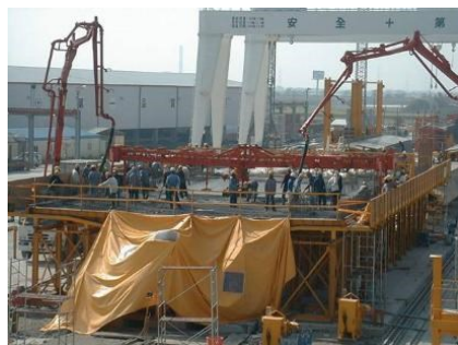
(d) Pouring concrete
