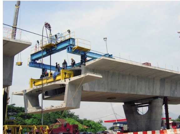
(d) Balanced cantilever erection with lifting frames
