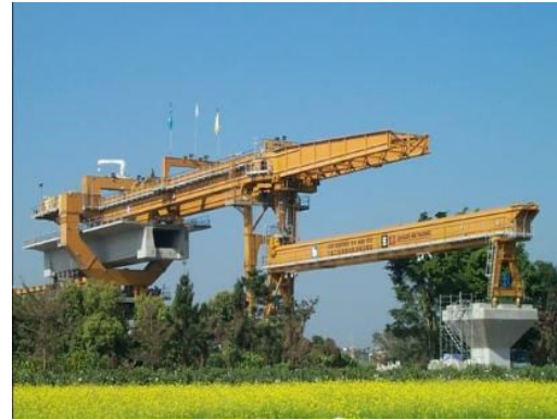
(d) Moving the girder forward
