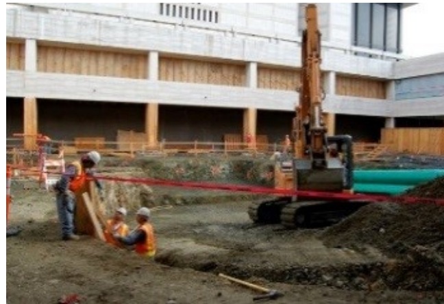
(d) Building Foundation.
