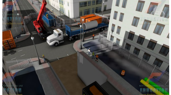
(d) Bringing a section to the site
