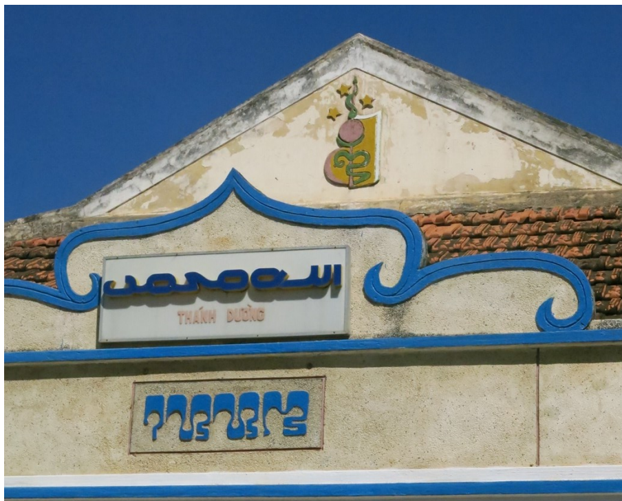
Fig. 27. Cham Awal mosque Bình Thắng, Bình Thuận province.
