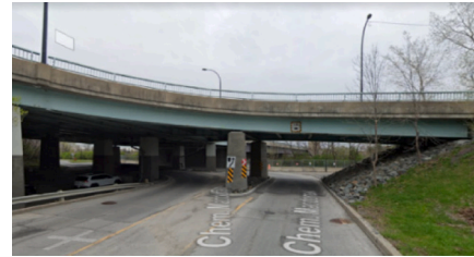
(d) Bridge 4: Chemin Macdonald
